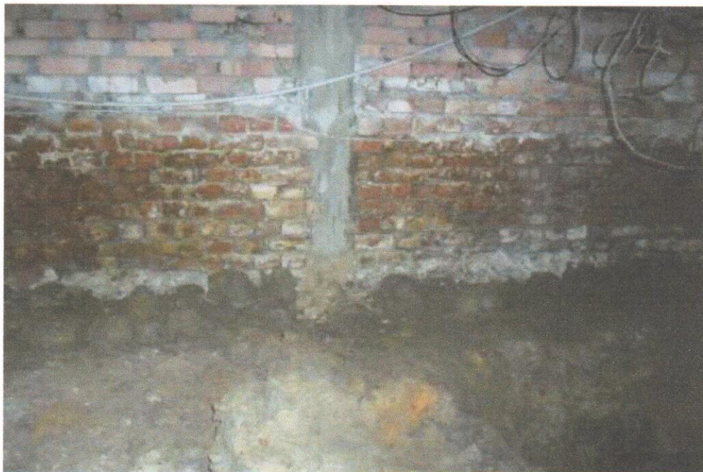
Fotografía No. 8. Apique No. 3
