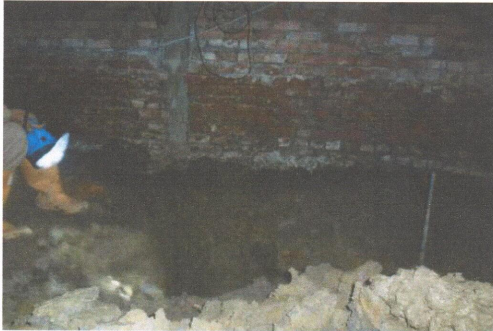
Fotografía No. 9. Apique No. 3
